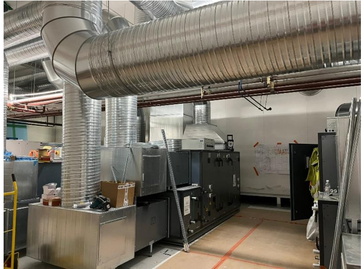
Kuva 1 2.krs C-lohko iv-koneita ja kanavia asennettu
