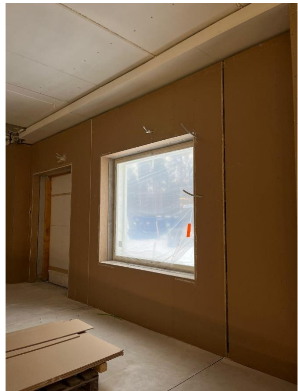
Kuva 3 1.krs A-lohko teknisten tilojen ulkoseinän levytystä
